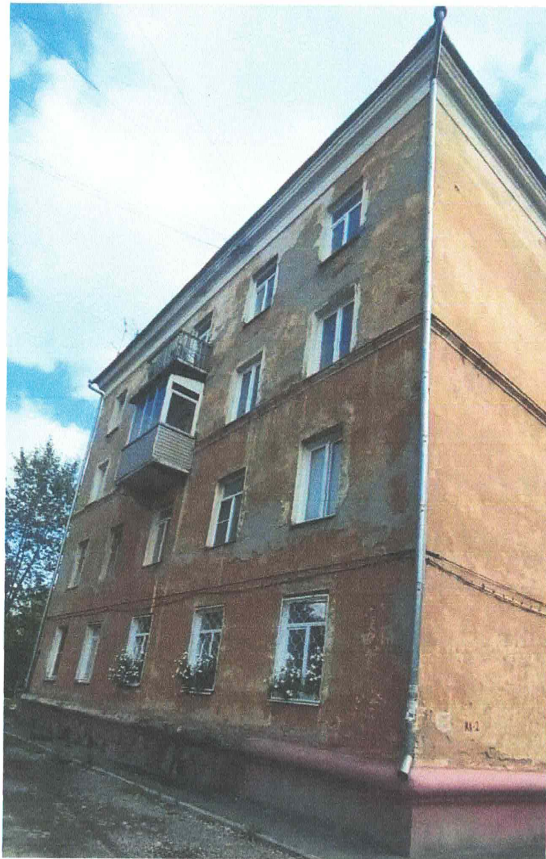
Фото 4. Общий вид торцевого фасада многоквартирного жилого дома.
