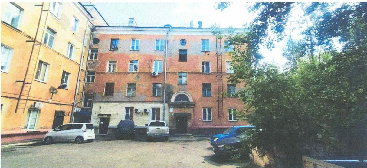
Фото 3. Общий вид части дворового фасада многоквартирного жилого дома.
