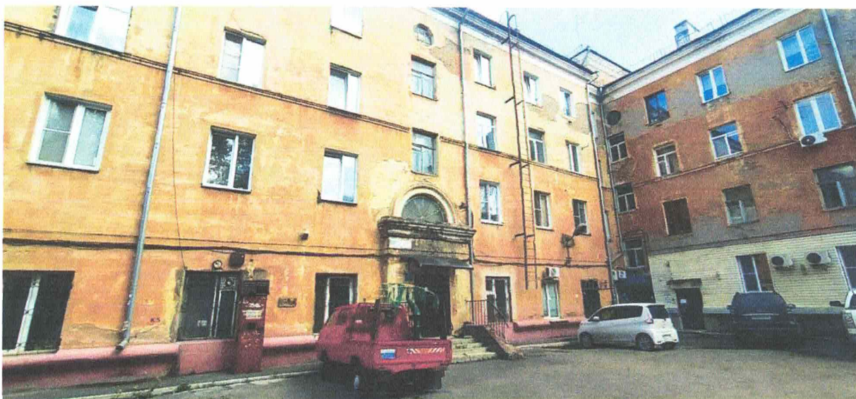
Фото 2. Общий вид части дворового фасада многоквартирного жилого дома.
