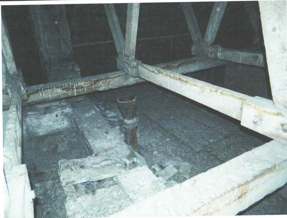
Фото 7. Выпуски канализационных стояков выведены в чердачное пространство.
