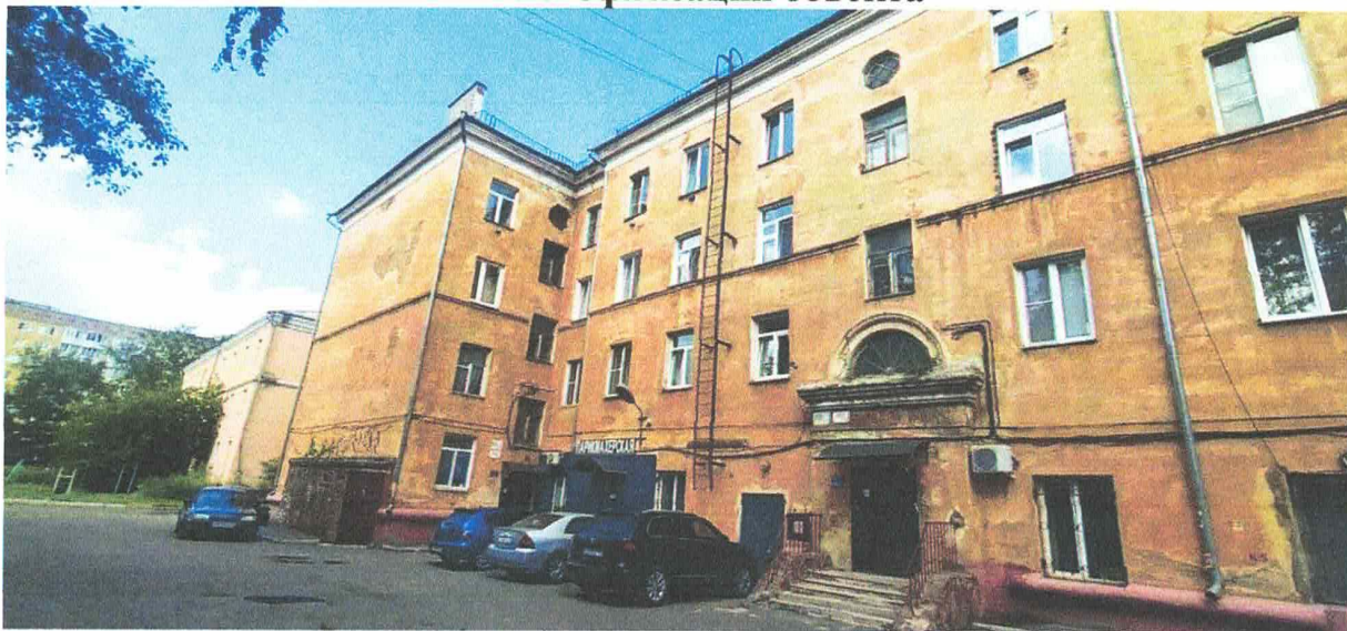
Фото 1. Общий вид части дворового фасада многоквартирного жилого дома.
